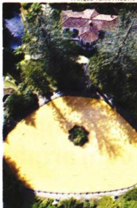
Tanque termal vai ser alvo de obras de modernização
